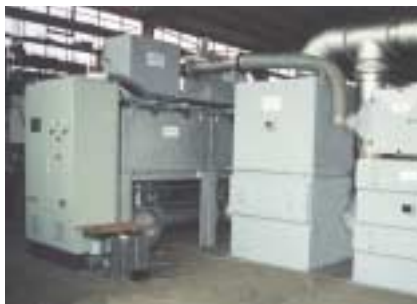
Bild 9: NTP-Anlage aus Plasmastufe und nachgeschaltetem Oxidationskatalysator
